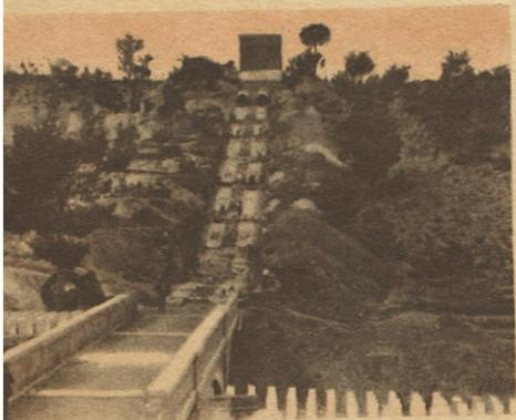
Construcción de las camas de los tubos en el sifón de Rompealbardas. (Trozo 3.º del Canal Bajo de Taibilla)
