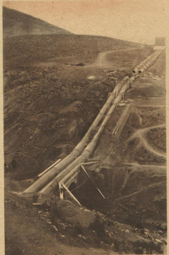
Portasifón y rama descendente del sifón de Rompealbardas. (Trozo 3.º del Canal Bajo de Taibilla)
