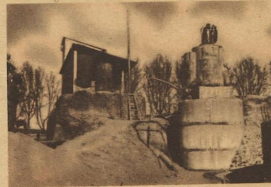
Cimentación por aire comprimido de las pilas del portasifón del Argos. (2.º Parte del Trozo 2.º del Canal Bajo de Taibilla)
