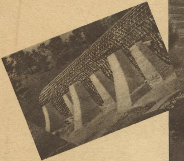
Cama de tubos de sifón de baja carga antes de hormigonar
