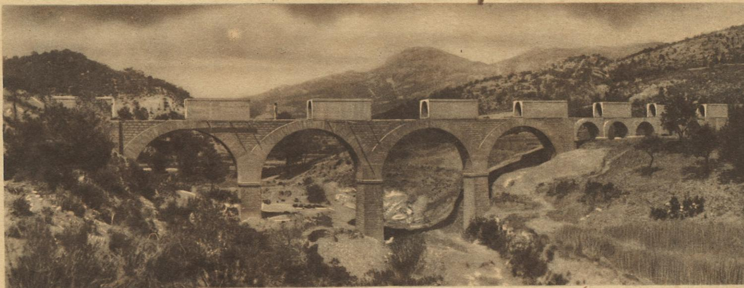
Construcción de la superestructura del acueducto sobre el río Pliego. (Trozo 5.º del Canal Bajo de Taibilla)
