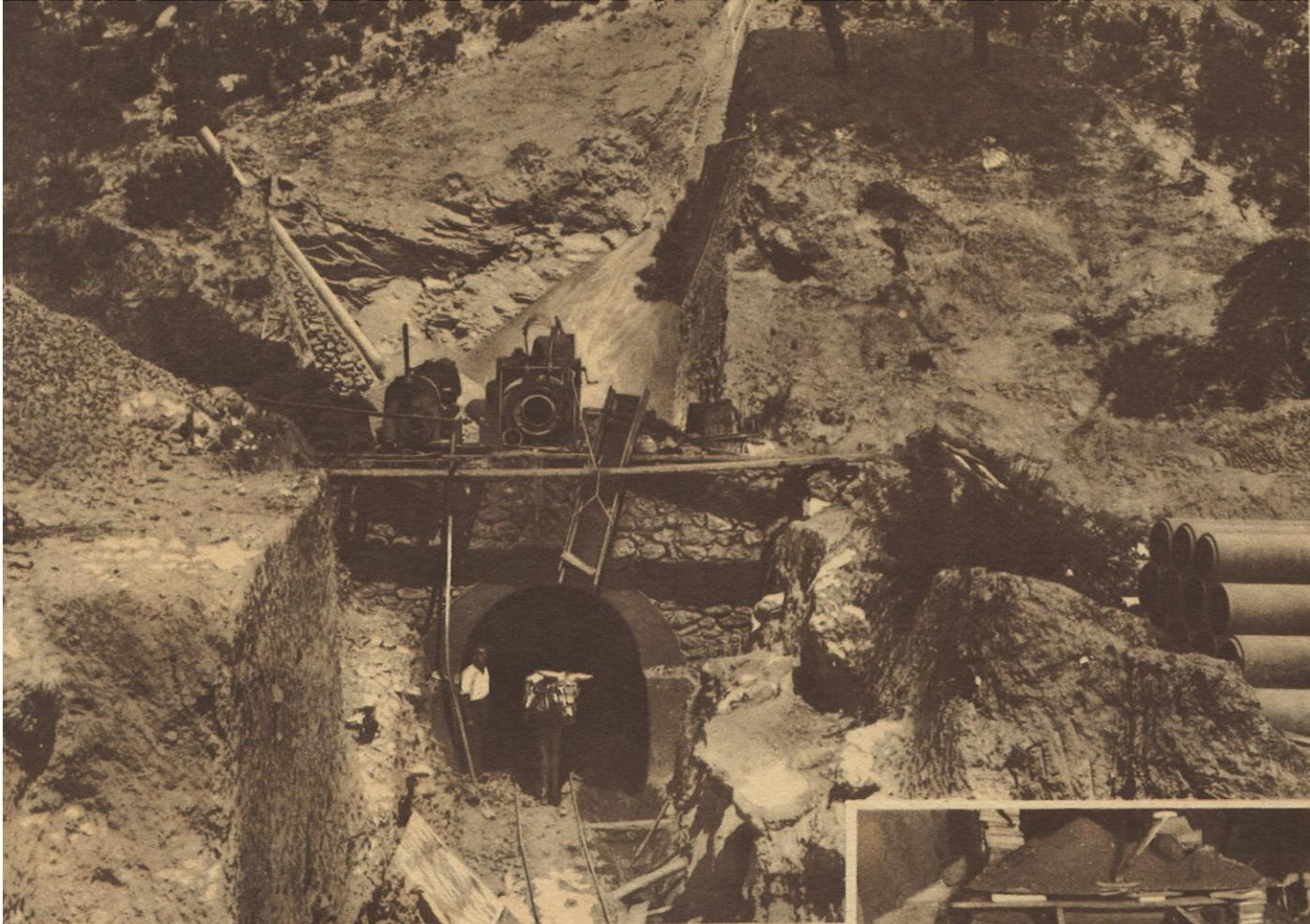
Boca de salida del Túnel del Roble, de 3.317,29 metros de longitud, con ataque sólo por las bocas. (5.º Trozo del Canal Alto de Taibilla)
