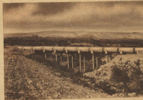
Tubos autorresistentes en el portasifón de los Charcones. Sifón de Socovos, de 1.971,51 metros de longitud y 90 metros de carga. (Trozo 4.º del Canal Alto)
