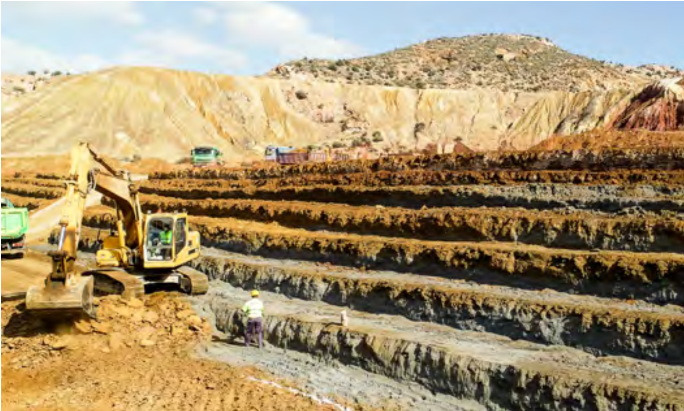
Detalle de obras en depósito San Cristóbal, Mazarrón
