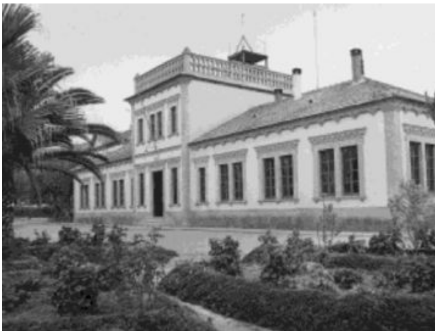
Figura 1.5. Fotografía tomada en la Estación Sericícola de La Alberca (Murcia), en funcionamiento como tal desde 1912 a 1976, actual IMIDA (Fuente: González Marín, 2001).
